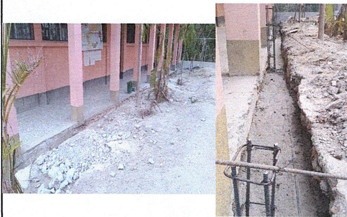
Foto 3: Vista del avance del muro de canal y mejoramiento del canal de aguas pluviales con block y su respectiva parrilla de metal frente dos aulas del centro educativo.
