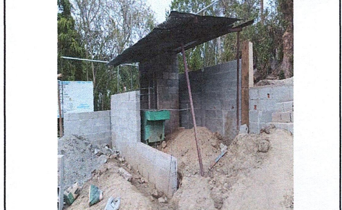
Foto 4: Vista del avance de mejoramiento y reparación de servicios sanitarios y sus accesorios del centro educativo.
